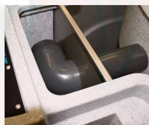
Figura 17.3 – Circunvalación o by-pass en funcionamiento
